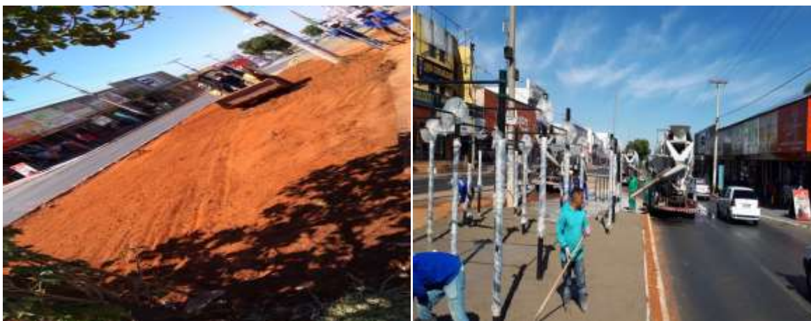
Ampliação de pontos de iluminação e substituição de luminárias na Quadra 404 do Recanto das Emas.
